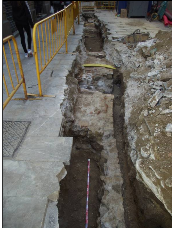
Fotografia 7. Detall del mur U.E.06
