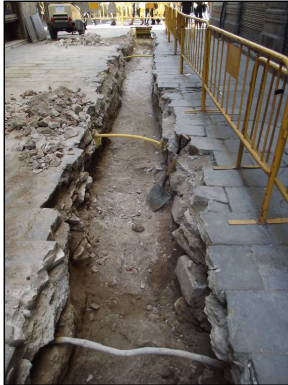
Fotografia 11. Detall de la rasa un cop realitzat el desmuntatge de les estructures.
