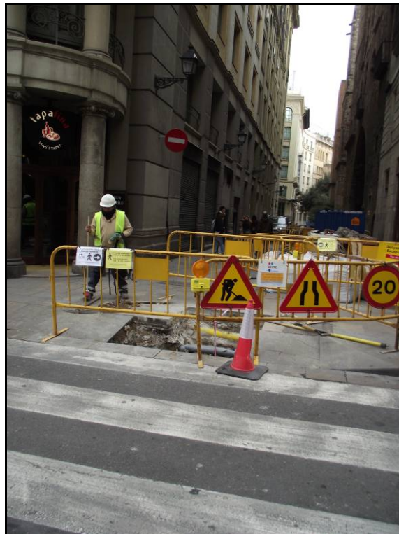
Fotografia 9. Amb la fletxa marquen la situació del mur U.E.10.
